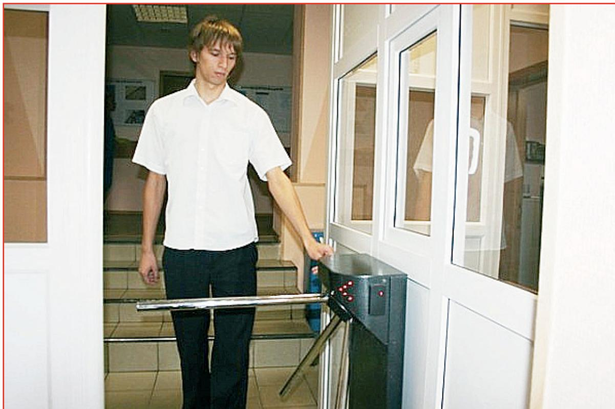
Организована система контроля доступа учащихся в здание общежития, установлен электронный турникет, который позволяет вахтеру осуществлять контроль доступа всех проживающих в общежитии с отображением их фамилии и имени и комнаты проживания на мониторе ПЭВМ.
